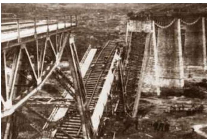
Η ανατίναξη της Γέφυρας του Γοργοποτάμου (25/11/1942)
