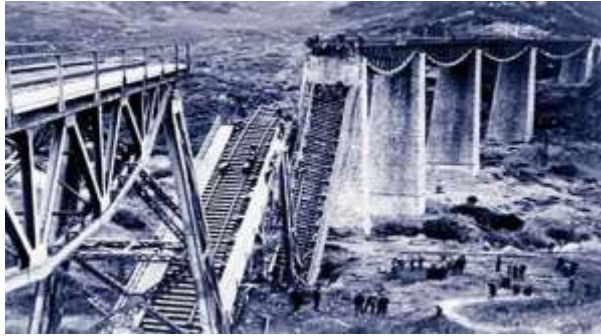
Η κατεστραμμένη γέφυρα του Γοργοποτάμου
